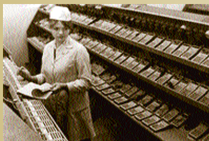
Дільниця електротренування мікрокалькуляторів НВО «Кристал». 1979 р.
