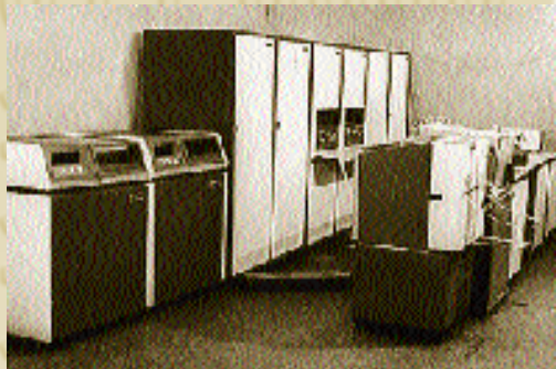
Двопроцесорний керуючий комплекс «М-7000» системи «АСВТ-М». Найкраще – «ворог» хорошому! Кінець 70-х рр. XX ст.
