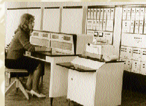
Напівпровідниковий обчислювальний комплекс «М-3000» агрегатної системи засобів обчислювальної техніки «АСВТ». Кінець 60-х рр. XX ст.
