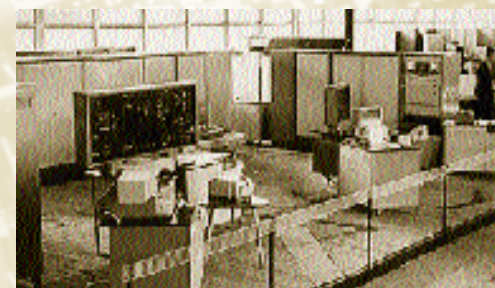
Ферит-транзисторна координуюча обчислювальна машина «КВМ-1» системи «СОУ-1», яка об'єднує машини «МППИ» та «УМ-1» в єдину багаторівневу систему. 1968 р.
