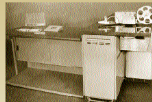
Цифровий спеціалізований комп'ютер «Київ-67», створений в Інституті кібернетики АН УРСР. Головний конструктор – В.П. Деркач. Використовувався при виробництві напівпровідникових приладів, у ньому вперше було реалізовано високий рівень мови спілкування і звуковий супровід технологічних процесів з метою їх контролю. 1967 р.
