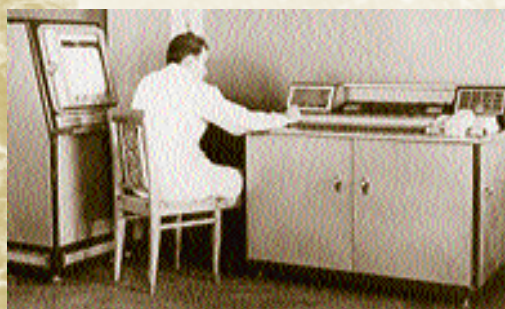
Ферит-транзисторна машина первинної переробки інформації «МППИ-1» тривірневої системи оперативного керування виробництвом системи СОУ-1. Початок 60-х рр. XX ст.
