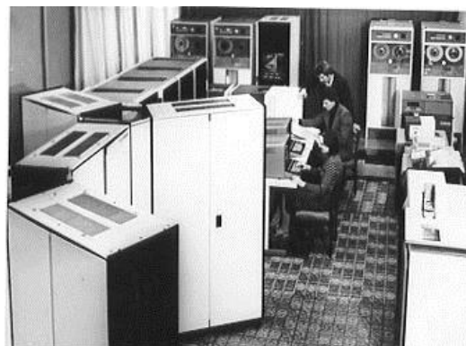
Экспедиционный геофизический вычислительный комплекс ПС 2000 производительностью 200 млн.опер./сек
