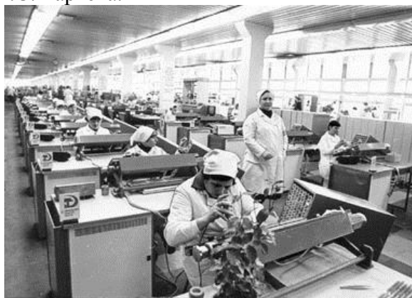
Автоматизированный участок монтажа (накруткой) для сборочных панелей СМ ЭВМ
